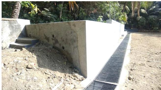
Un mur de soutènement et une dérivation pour les eaux de pluies finalisés
